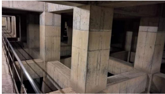
(図 2-11)西郷通調節池内部
