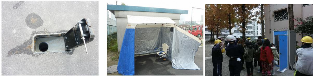
(図 2-7) マンホールトイレ・説明会の様子
