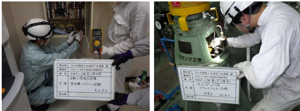
(図 2-5)設備の点検作業
