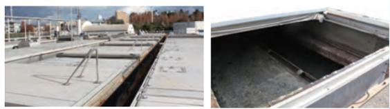
2時間かけてゆっくり流す間に反応タンクでできた塊を沈ませ、上澄みのきれいな水を取り出します。この段階で透明な水に見えます。沈殿した塊の一部は反応タンクに戻し、余分な汚泥は汚泥処理施設へ送ります。
