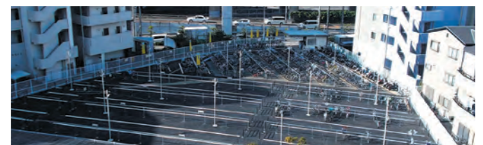
大日駅北第1自転車駐車場
