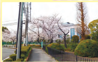
⑨庭窪浄水場
