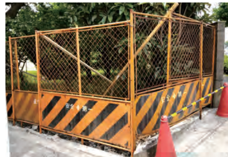
ブロック塀仮撤去(佐太小)
