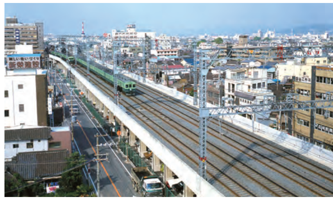
京阪電車土居駅周辺 高架複々線
