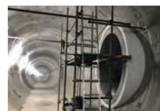
管の接続箇所
