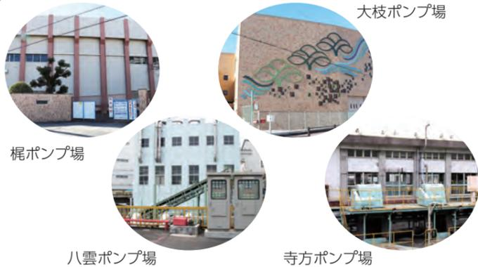
管に勾配をつけることによって汚水を処理場まで流していますが、処理場までの距離が長くなれば地下深くまで掘ることが必要になります。市では4カ所のポンプ場を配置し、それぞれの施設でポンプアップすることで処理場まで汚水の流下を可能としています。
