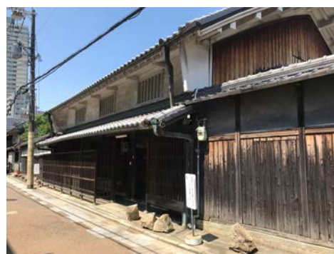
写真 3-1 文禄堤側の外観（現状）
