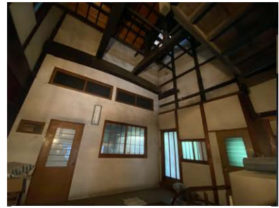
写真 2-1 大屋根の垂木、煙出し
