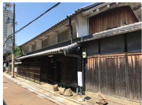
写真 3-1 文禄堤側の外観（現状）
