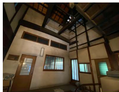
写真 2-1 大屋根の垂木、煙出し
