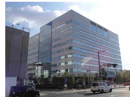
新市庁舎(平成28年)
