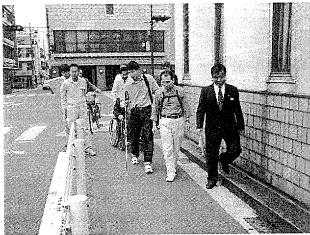
・守口75号線歩道部分の 状況
