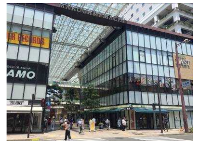
多様な都市機能を導入した再開発 (高松市)
