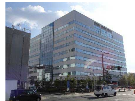
新市庁舎(平成28年)
