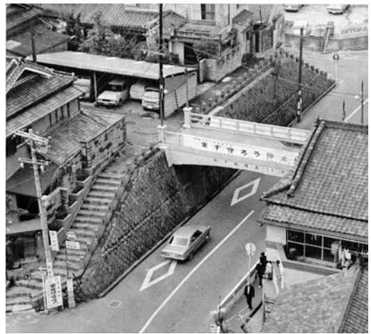
図 3-8 かつての文禄堤の階段部の石積み
