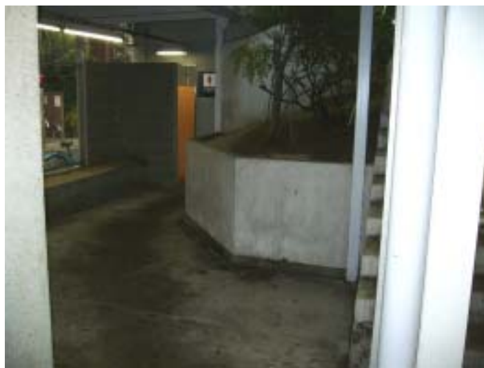
土居駅のトイレ前
