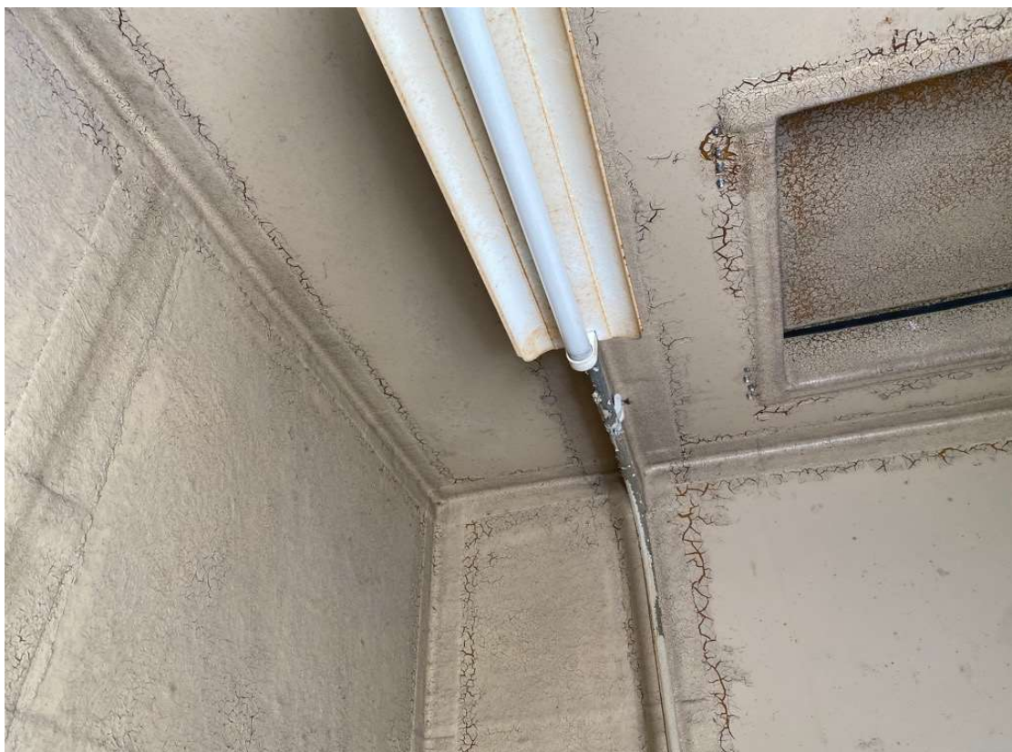
浄化槽写真(その5)
