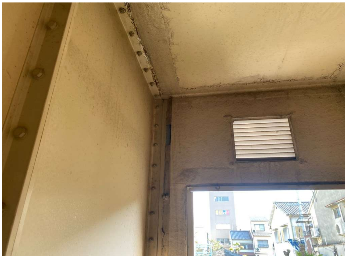
浄化槽写真(その8)
