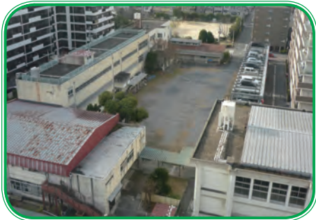
解体される旧土居小学校
