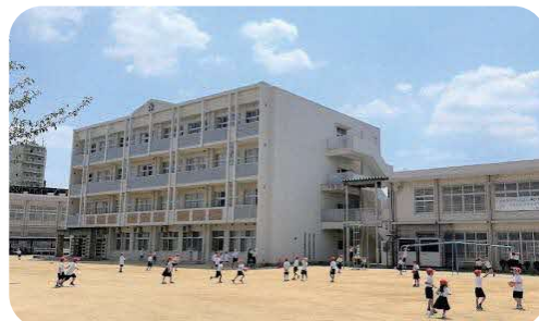
校舎整備が予定されている守口小学校
