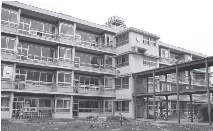
耐震補強工事予定の梶小学校校舎棟
