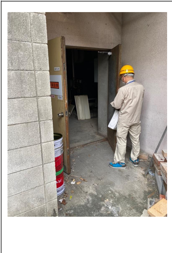
保管場所（電気室 鍵付き）
