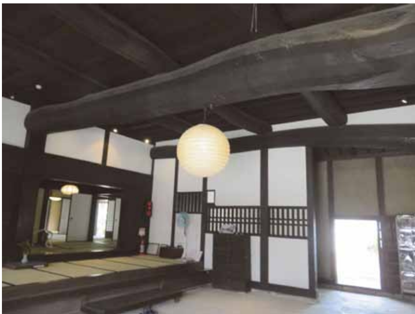
(上)中西家住宅 式台付大玄関 (下)中西家住宅 土間の大梁
