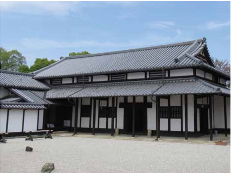
(上)中西家住宅 大門 (下)中西家住宅 主屋
