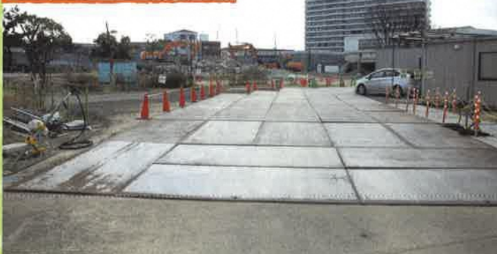
南側教室棟、撤去後
