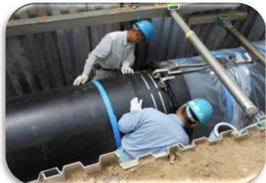
耐震管を使用した基幹管路の施工風景
