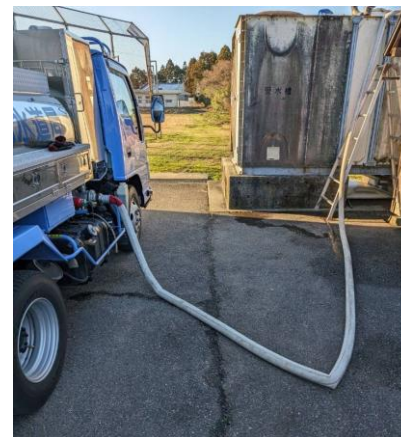
受水槽へ補給する活動
