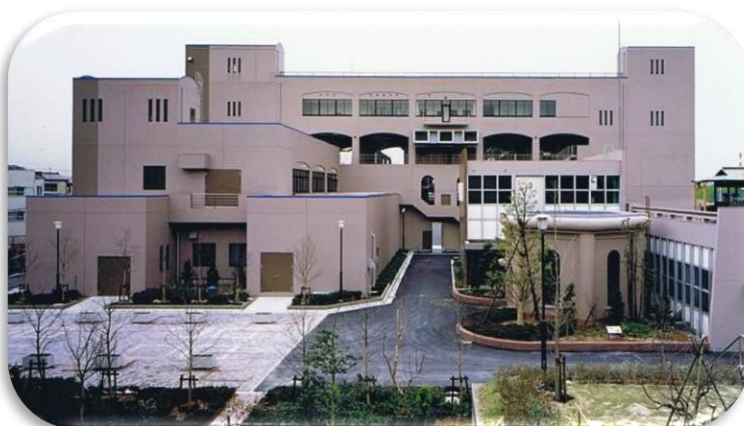
高度浄水処理施設
