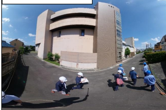
写真:高度処理棟外観
