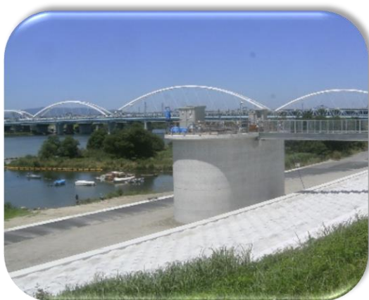
大阪府・大阪市・守口市による 共同取水施設
