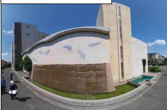
写真:15～20号急速ろ過池外
