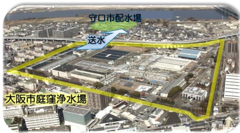
庭窪浄水場の共同運用
