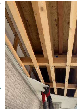
撤去状況(イメージ)
