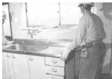
写真 流し台の撤去
