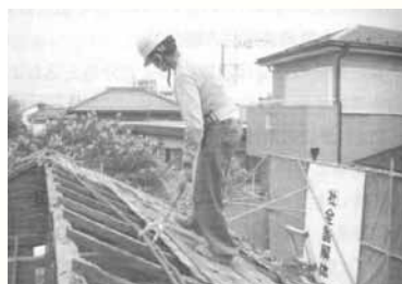
写真 屋根の解体
