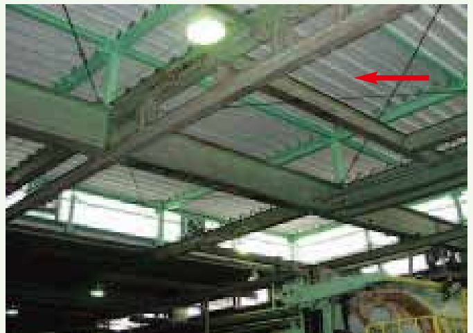
屋根用折版断熱材（折版屋根裏）
