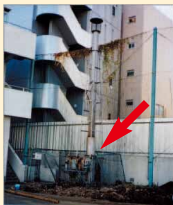
廃棄物焼却炉
