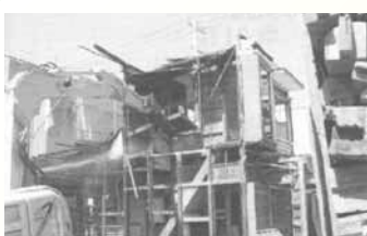
写真 2階妻側からの解体
