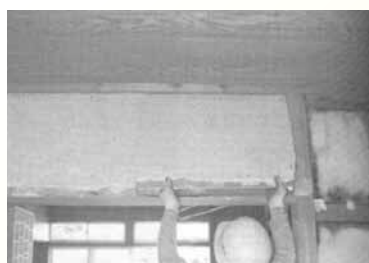
写真 石膏ボードの撤去
