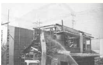
写真 2階妻側からの解体
