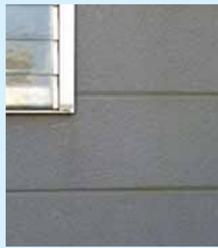
石綿板（窯業系サイディング）
