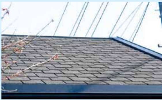
石綿含有住宅化粧用スレート（屋根）
