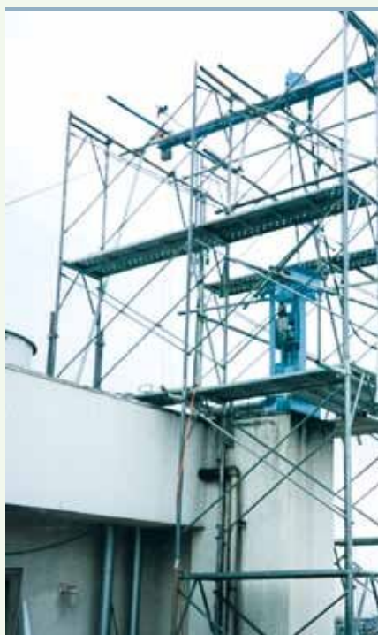
煙突上部及び灰出し口を隔離養生
