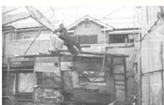
写真 1階桁側の解体
