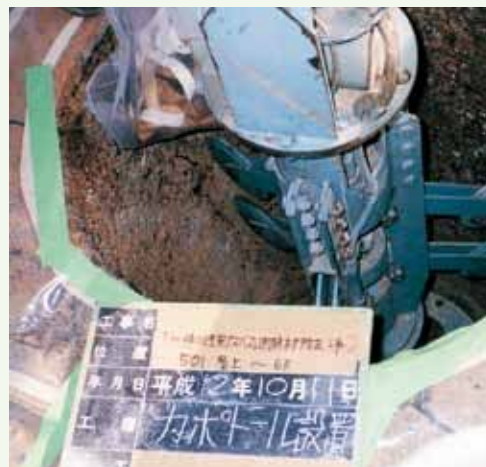
乾式除去の専用機械
