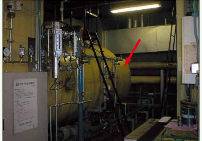
石綿含有保温材（ボイラ外周部）
