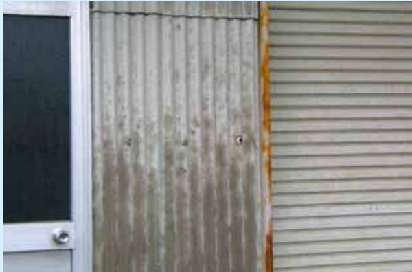
石綿スレート（屋根・外壁）
