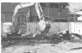
写真 基礎の解体
