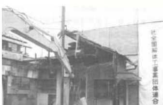
写真 1階妻側からの解体
