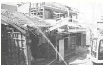
写真 桁側からの解体
