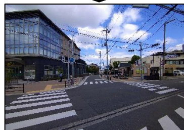
◀ 庭窪農協前交差点整備後 (平成 30(2018)年度)
