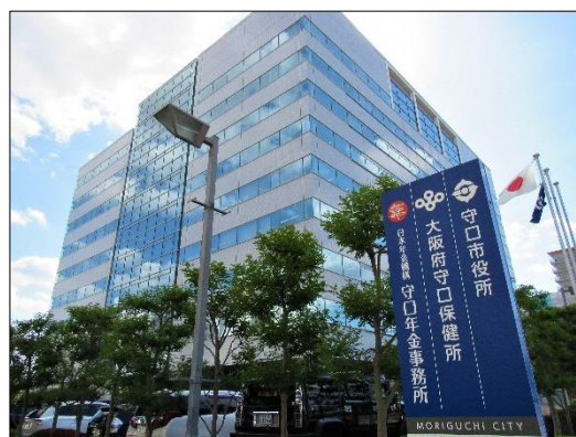
▲守口市役所 庁舎
