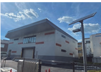
▲南部地域防災センターの整備 (R7)
