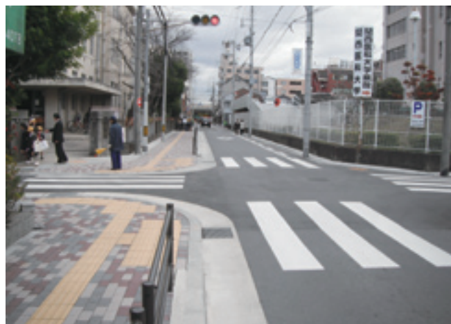
既存生活道路の整備
