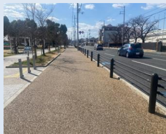
▲馬場菊水線【歩道整備】
