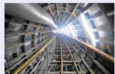
▲松下菊水放流幹線 内部(工事中画像)
