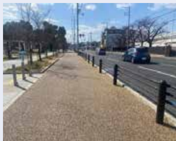
▲馬場菊水線【歩道整備】
