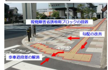
道路のバリアフリー化整備事例
