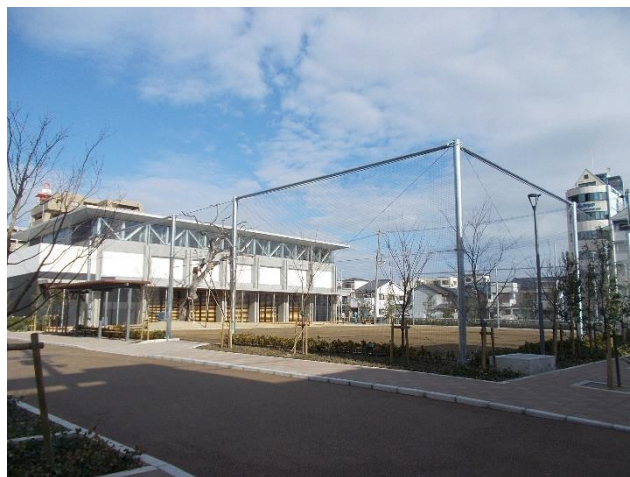
たきい公園（令和 3 年 12 月整備）
