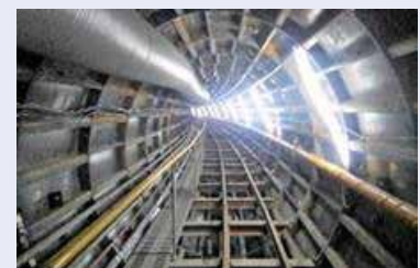
▲松下菊水放流幹線 内部(工事中画像)
