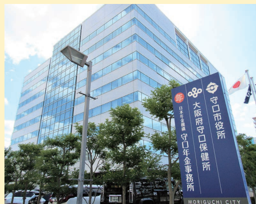
▲守口市役所 庁舎
