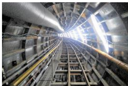
▲松下菊水放流幹線内部（工事中画像）
