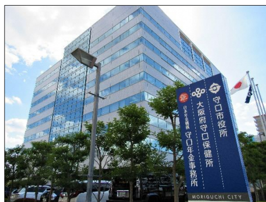
▲ 守口市役所 庁舎
