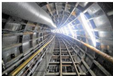
▲(仮)松下菊水放流幹線内部 (工事中画像)
