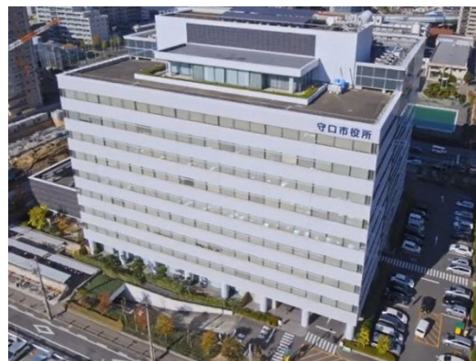
▲守口市役所 庁舎
