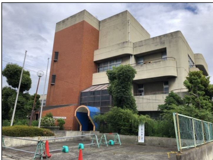
【現況写真①】
